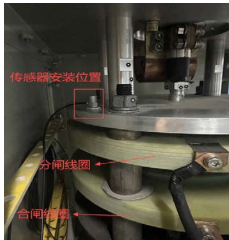
图 8 振动传感器安装位置
